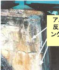
コンクリート中の骨材(鉱物)とアルカリ性溶液との化学反応(アルカリシリカ反応)によって、局所的な容積膨張が生じ、コンクリートにひび割れを生じさせるとともに、強度低下が生じる現象
