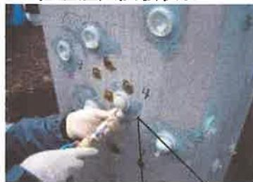
リチウム型ゼオライトと微粒モルタルセメントを混合したペースト材のひび割れ注入試験を実施
